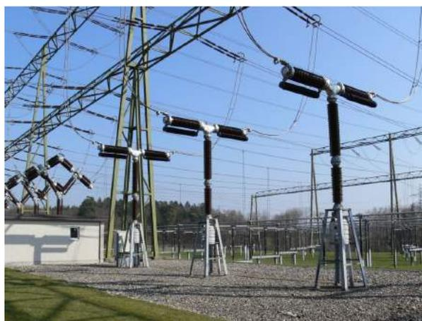
ill. 2 : Disjoncteurs de puissance de 380 kV reliés essentiellement par des câbles verticaux aux appareils voisins : cette configuration permet de grands déplacements sismiques sans provoquer la tension des câbles.
