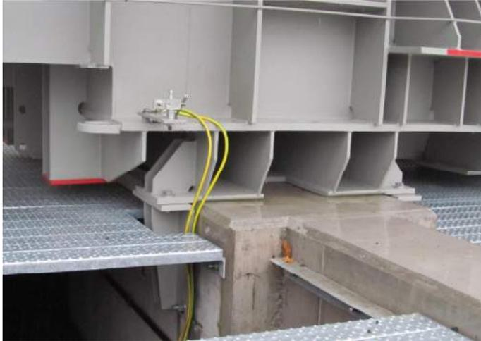
ill. B.1: Transformateur 220 kV / 70 MVA – Zone sismique Z3b – Ancrages (8 pces. démontables) directement sur la fondation (avec l'autorisation d'axpo).
