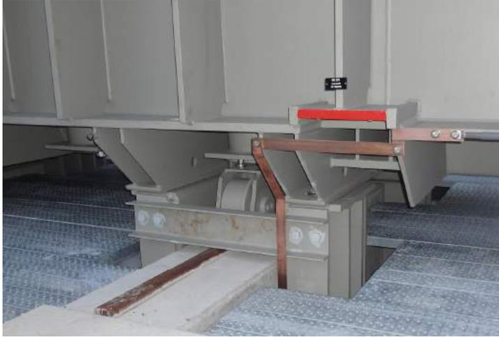
ill. B.4: Transformateur 110 kV / 125 MVA – Zone sismique Z2 – Ancrages (4 pcs. démontables) avec roues (avec l'autorisation d'axpo).
