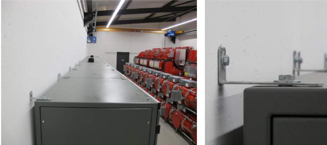
ill. E.3/E.4: Sécurisation d'armoires de commande avec équerres contre le mur (axpo AG)
