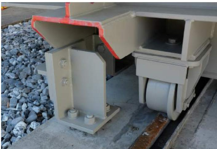
ill. B.3: Transformateur 110 kV / 60 MVA – Zone sismique Z2 – Ancrages (4 pces. démontables) avec roues (avec l'autorisation d'axpo).
