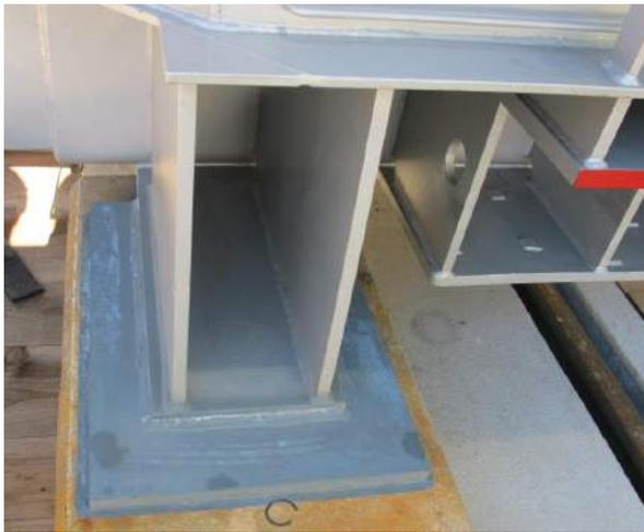
ill. B.2: Transformateur 236 kV / 60 MVA – Zone sismique Z3b – Cadre de renforcement soudé sur plaques d'ancrage coulées dans le béton (avec l'autorisation de ewz).
