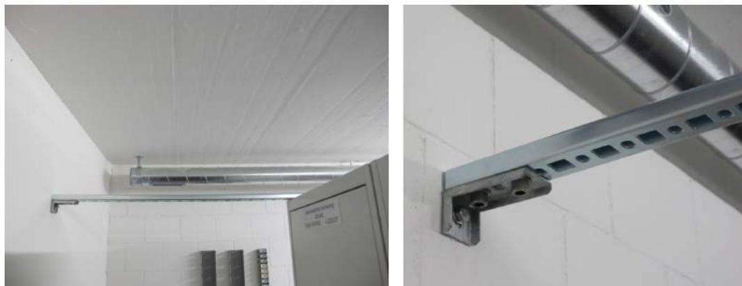
ill. E.6/E.7: Sécurisation d'armoires de commande au centre d'une pièce jusqu'au mur (axpo AG)
