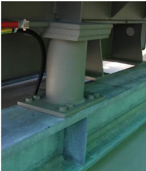
ill. B.5: Transformateur 50 kV / 25 MVA – Zone sismique Z2 – Ancrage sur une fondation existante renforcée (avec l'autorisation de energie thun).
