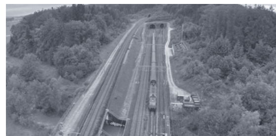
Un jalon de plus: le nouveau tronçon de Rail2000.
