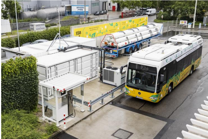
Abbildung 28: Wasserstofftankstelle der Stuttgarter Strassenbahnen AG
