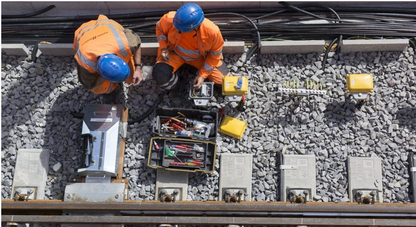
Einbau Weichenheizung
