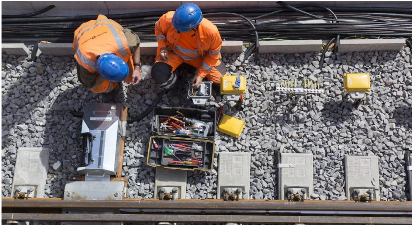
Montage d'un chauffage d'aiguillage automatique
