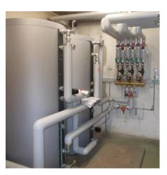
Neue Luft-Wasser-Wärmepumpe im Unterwerk Muttenz (Bild 1 und 2). Ebenfalls wurden die Speicher und der Heizungsverteiler erneuert (Bild 3).
