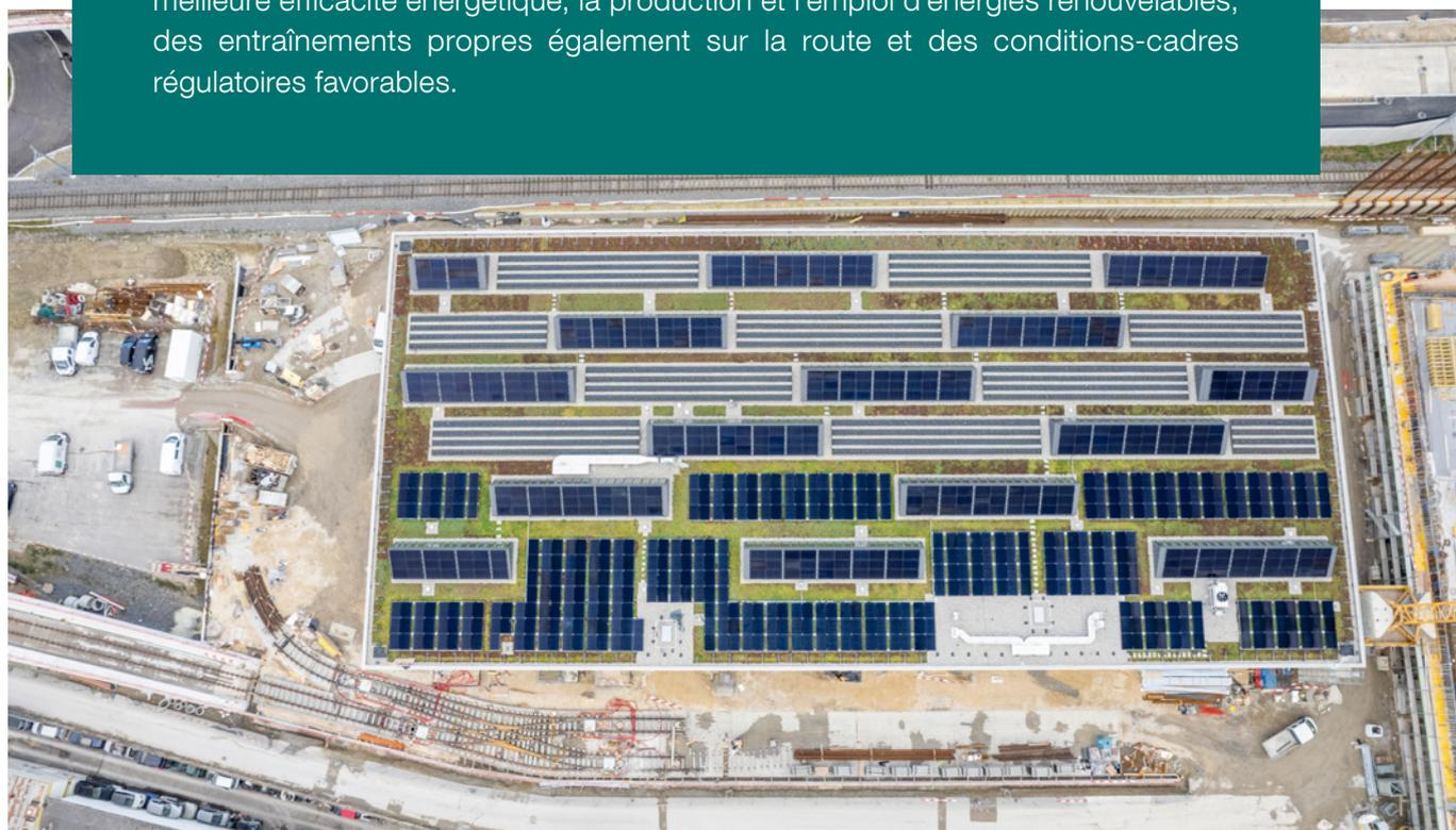
*Le toit du nouveau dépôt de tram sert lui aussi à produire du courant solaire. Les tl emploient principalement cette électricité – environ 0,32 gigawattheure – pour l'exploitation des installations de dépôt et d'entretien.*
