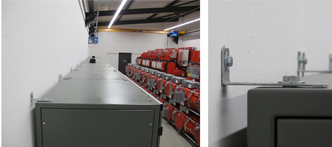
Bild E.3/E.4: Sicherung von Steuerschränken mit Stahlwinkeln an Wand(axpo AG)
