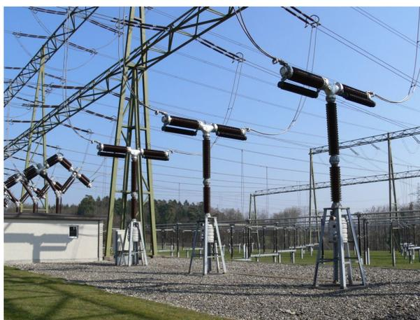
Bild 2: 380 kV-Leistungsschalter, die über im Wesentlichen vertikale Leiterseile mit den Nachbar-Apparaten verbunden sind: Diese Konfiguration lässt grosse Erdbebenverschiebungen zu, ohne dass die Leiterseile straff werden.
