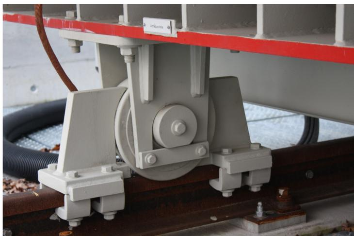
Bild B.6: Trafo 110 kV / 40 MVA – Erdbebenzone Z1 – Verankerung mit zwei Hemmschuhen pro Rolle. Es ist auf das Ausknicken in Querrichtung und die Stabilität der Schiene zu achten; NUR in der Erdbebenzone Z1 anwendbar (mit Erlaubnis von ekz).
