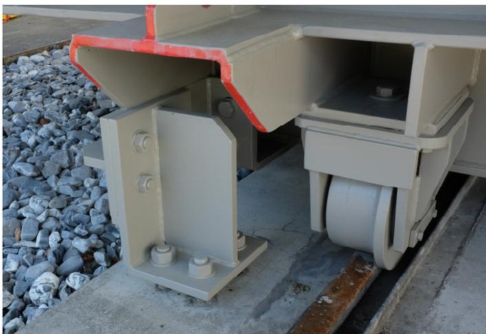
Bild B.3: Trafo 110 kV / 60 MVA – Erdbebenzone Z2 – Verankerungen (4 lösbare) mit Fahrrollen (mit Erlaubnis von axpo).
