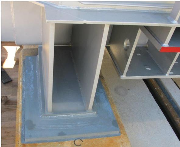
Bild B.2: Trafo 236 kV / 60 MVA – Erdbebenzone Z3b - Verschweissung mit Verstärkungsrahmen auf einbetonierte Verankerungsplatten (mit Erlaubnis von ewz).
