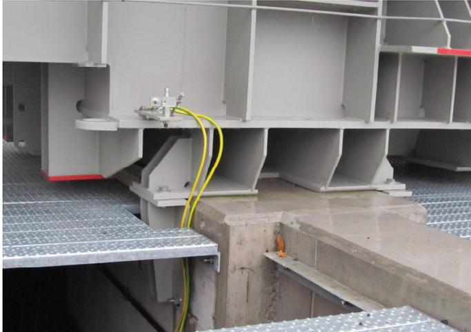
Bild B.1: Trafo 220 kV / 70 MVA – Erdbebenzone Z3b – Verankerungen (8 lösbare) direkt auf Fundament (mit Erlaubnis von axpo).
