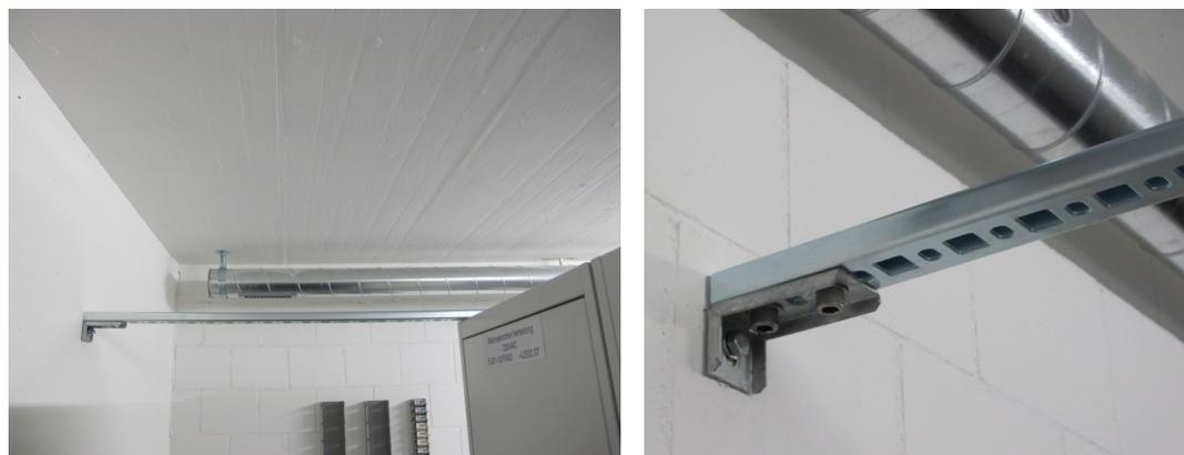
Bilder E.6/E.7: Sicherung von Steuerschränken in Raummitte bis an die Wand (axpo AG)
