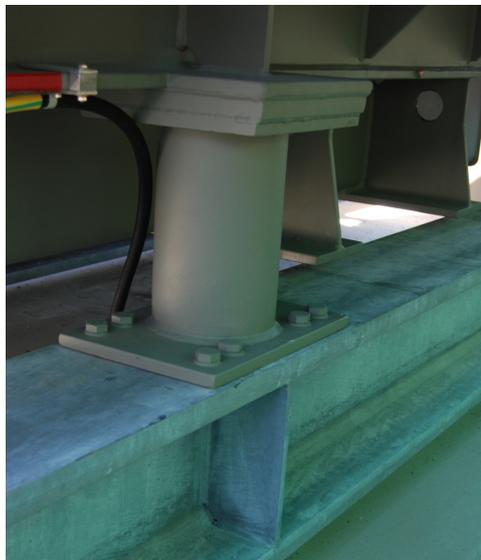
Bild B.5: Trafo 50 kV / 25 MVA – Erdbebenzone Z2 – Verankerung auf ein verstärktes bestehendes Fundament (mit Erlaubnis von energie thun).
