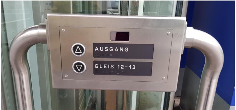
Relief- und Braille-Beschriftung auf einem Lift-Stockwerktableau
