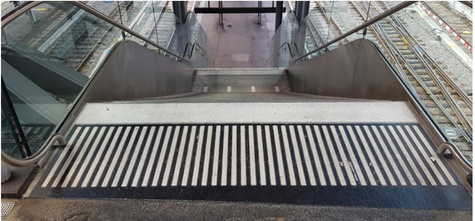
Treppenauf-/abgang mit Anfangsmarkierung und Zwischenabsatzmarkierung (Baggerzähne)
