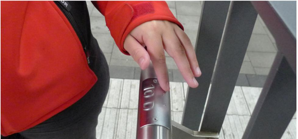
Relief- und Braille-Gleisbeschriftung auf einem Handlauf
