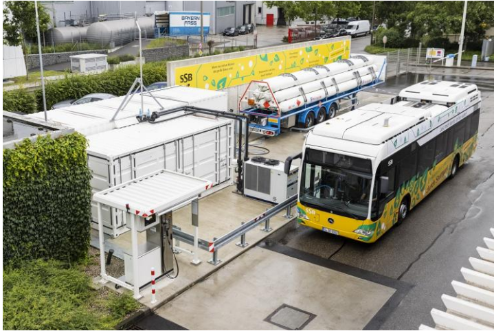
Abbildung 28: Wasserstofftankstelle der Stuttgarter Strassenbahnen AG
