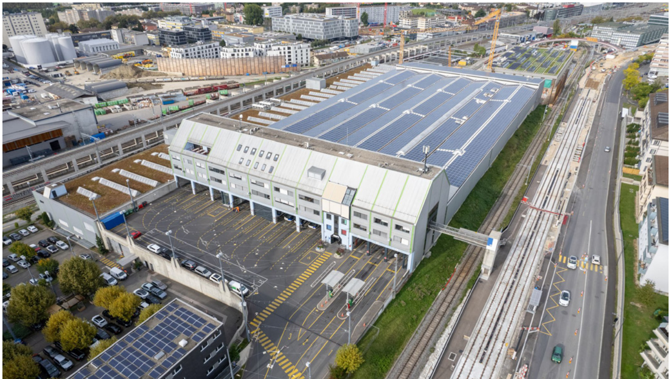
Das Dach des tl-Busdepots Perrelet in Lausanne ist vollständig mit Solarpanels versehen.
