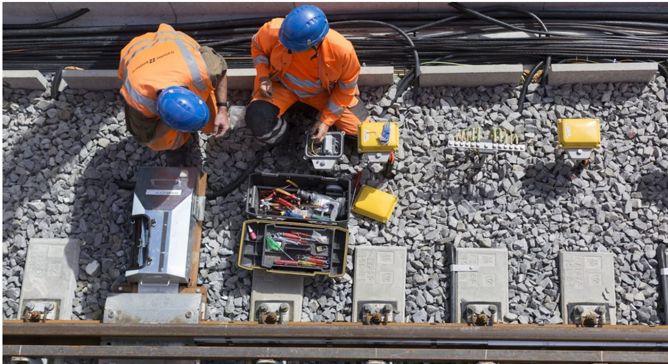
Einbau Weichenheizung
