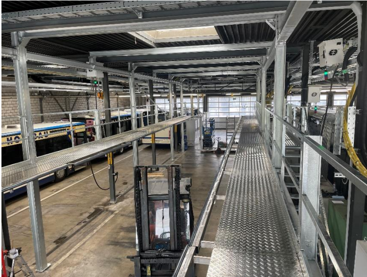
Einbau Dacharbeitsplatz im Bestand
