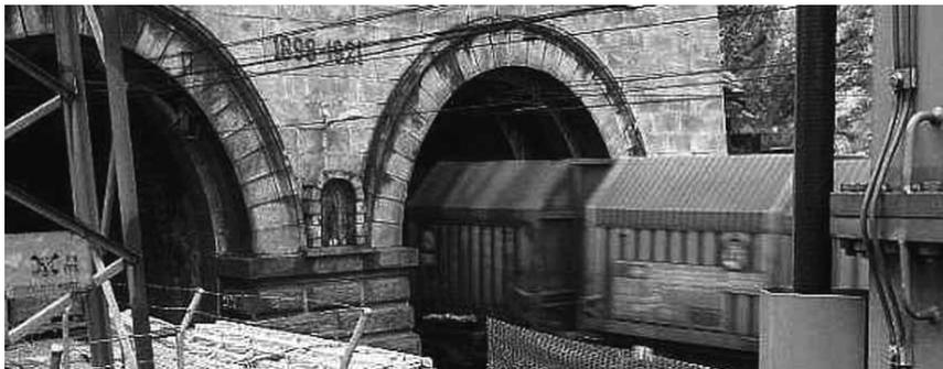
Les profils d'espace libre des anciens tunnels sont critiques pour les profils hauts, comme ici au portail sud du Simplon. La marge est infime si les coins supérieurs des wagons ne sont pas en biais ou pour des camions de la chaussée roulante de 4 m de hauteur aux angles.
